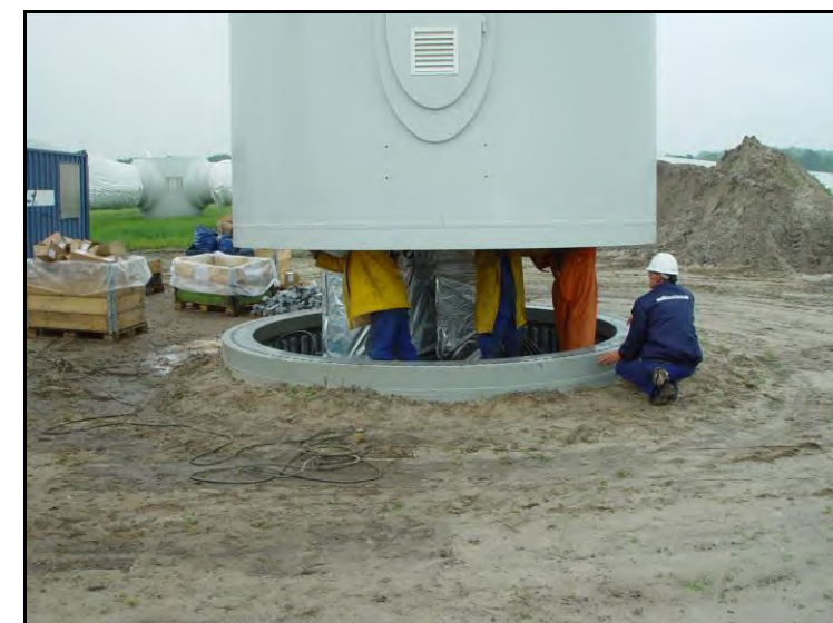
Photographie 12 : Montage du mât sur la fondation
