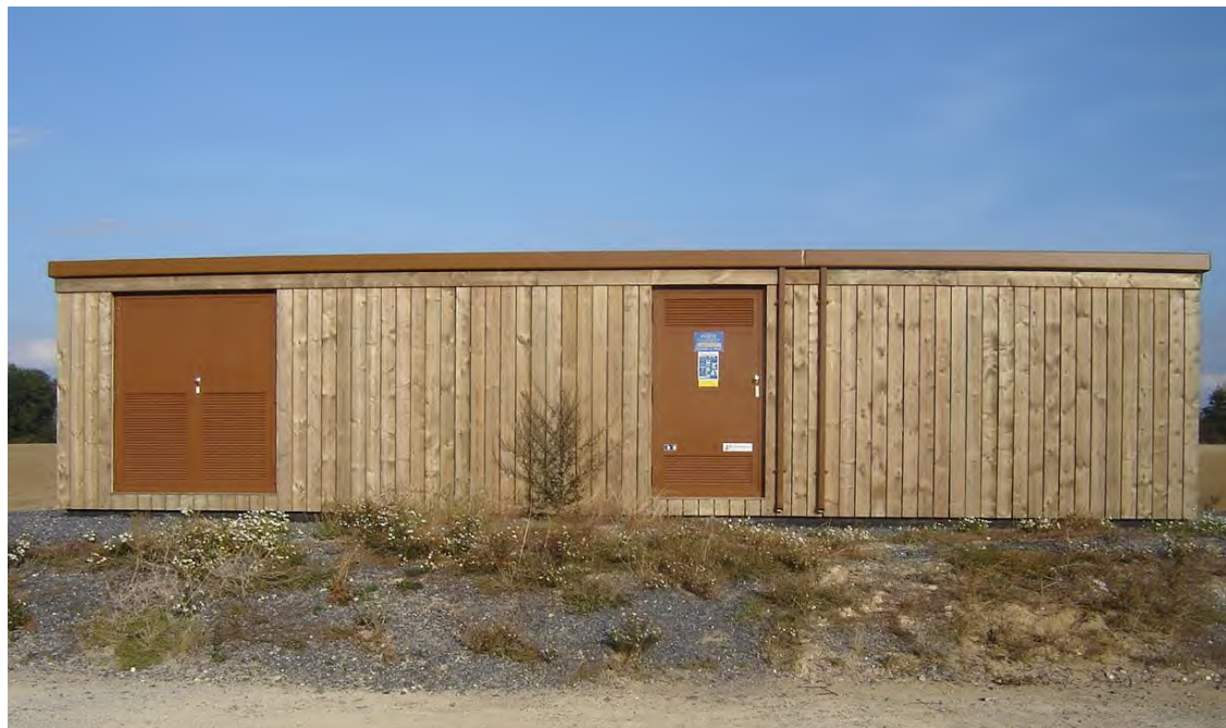
Photographie 4 : Exemple de poste de livraison (bardage bois)
