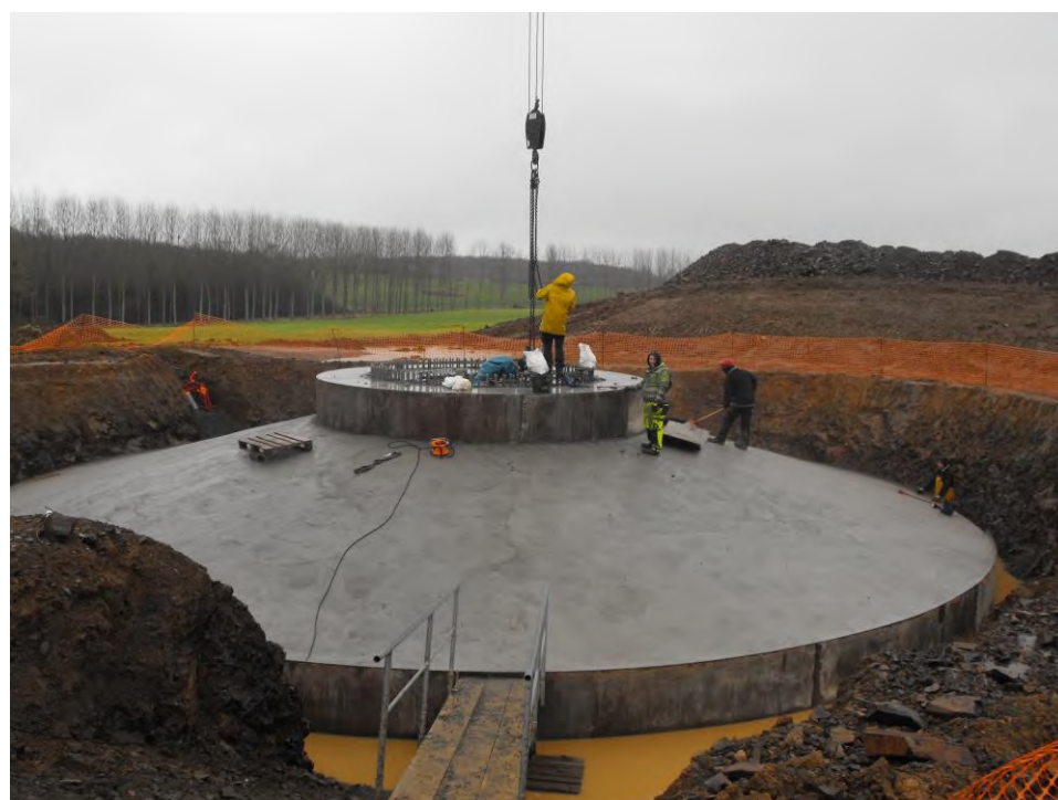
Photographie 8: Fondation après coulage béton
