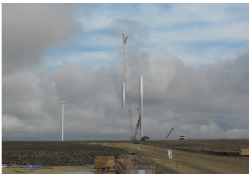
Photographie 13 : Montage de la troisième section du mât
