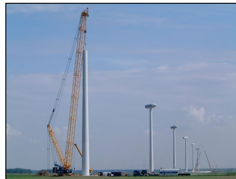
Photographie 15 : Un parc de neuf éoliennes Vestas V80 en construction
