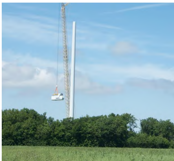
Photographie 14 : Montage de la nacelle
